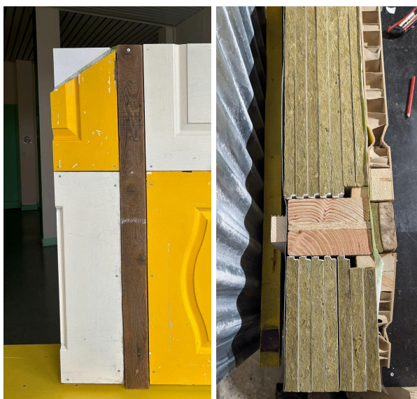
Joint vertical entre panneaux
